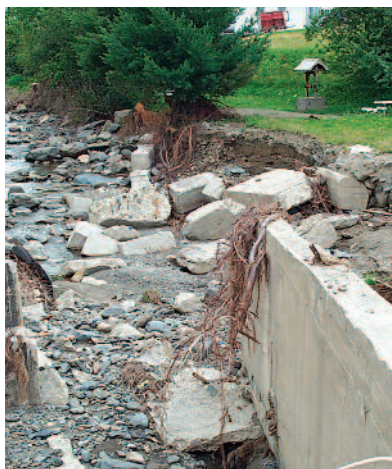
Les structures artificielles détruisent la rive et endommagent l'habitat du poisson.
