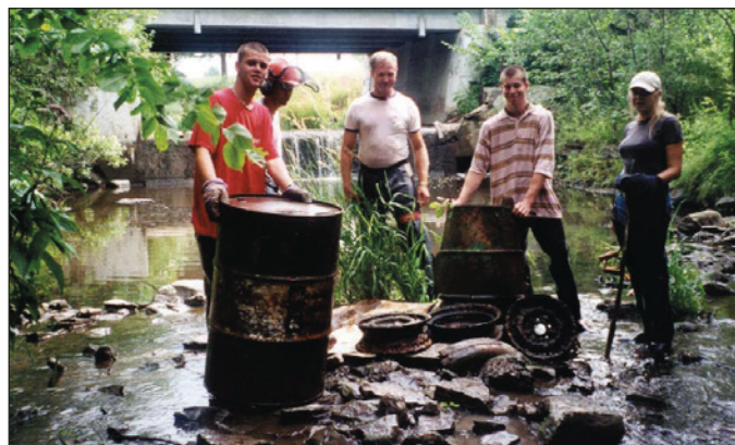
Photo 18 : Travaux de nettoyage
