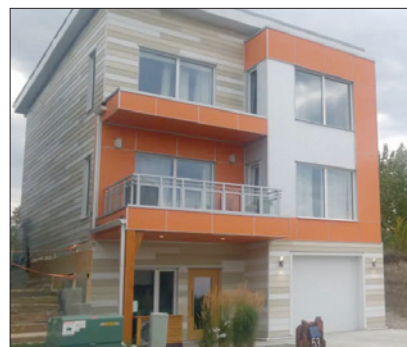
La maison passive bénéficie du chauffage solaire, « entrant » par les grandes fenêtres du côté sud, complété par un chauffage électrique utilisé au besoin.
