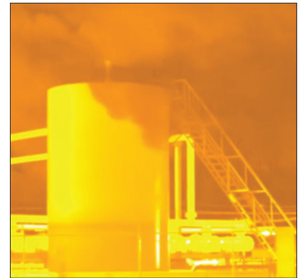
La photo de gauche est ce que l'on voit à l'œil nu. Celle de droite est celle captée par une caméra infrarouge qui nous montre la fuite de méthane. Source : « Do you see the methane leak billowing from the tank? »
